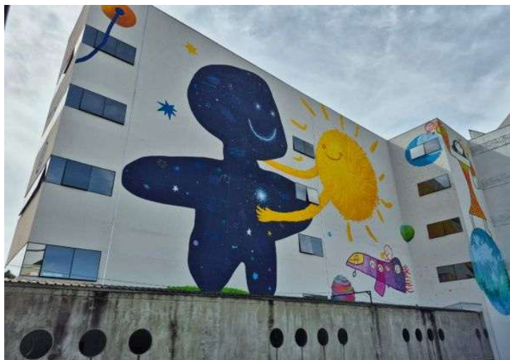
AMPLIAÇÃO E REFORMA DE HOSPITAL COM 1.713,00M 2
